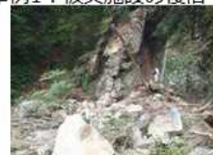
令和2年7月豪雨による歩道法面の崩落（三段峡線歩道）
